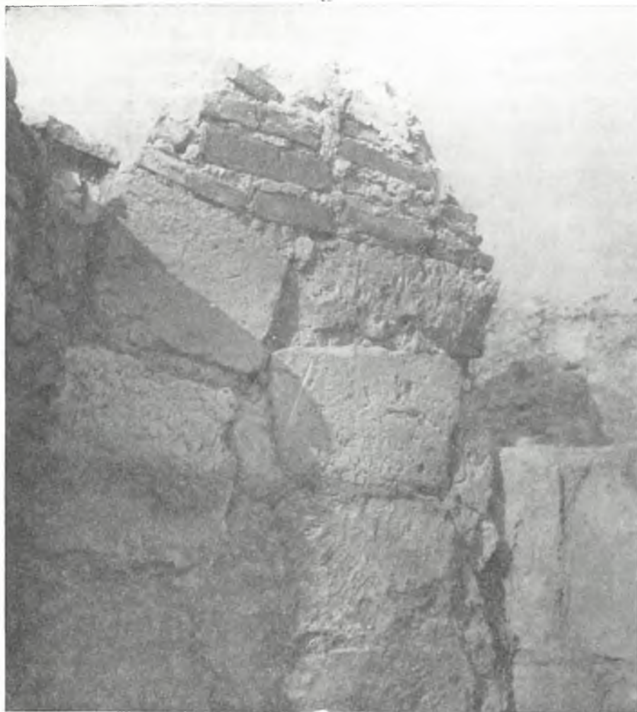
Обр. 9. Съединителен зид между тухлената колона и западната стена на югоизточната кула
