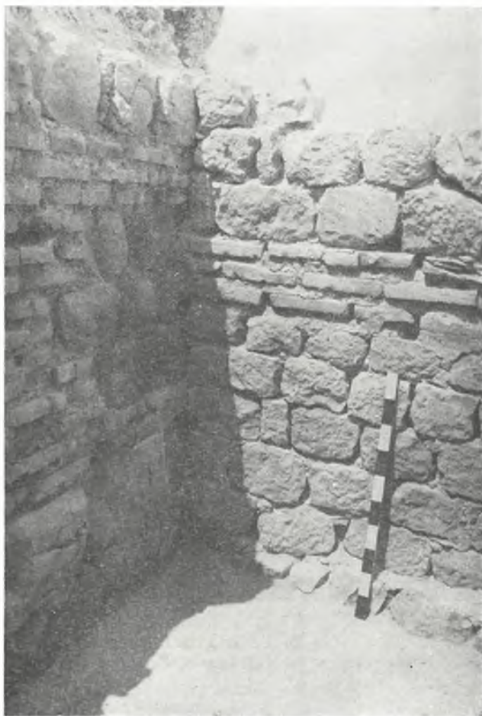
Обр. 7. Част от крепостната стена Fig. 7. Part'e du mur d'enceinte
