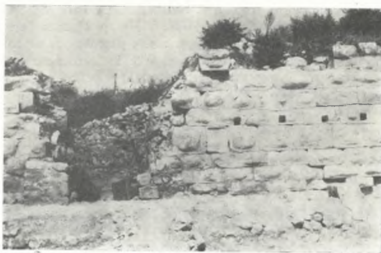
Обр. 2. Входът на западната крепостна стена Abb. 2. Eingang an der westlichen Festungsmauer
