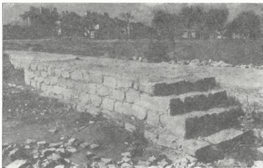
Обр. 24. Еднораменна стълба на външната крепостна стена Fig. 24. Escalier à une rampe du mur d'enceinte extérieur
