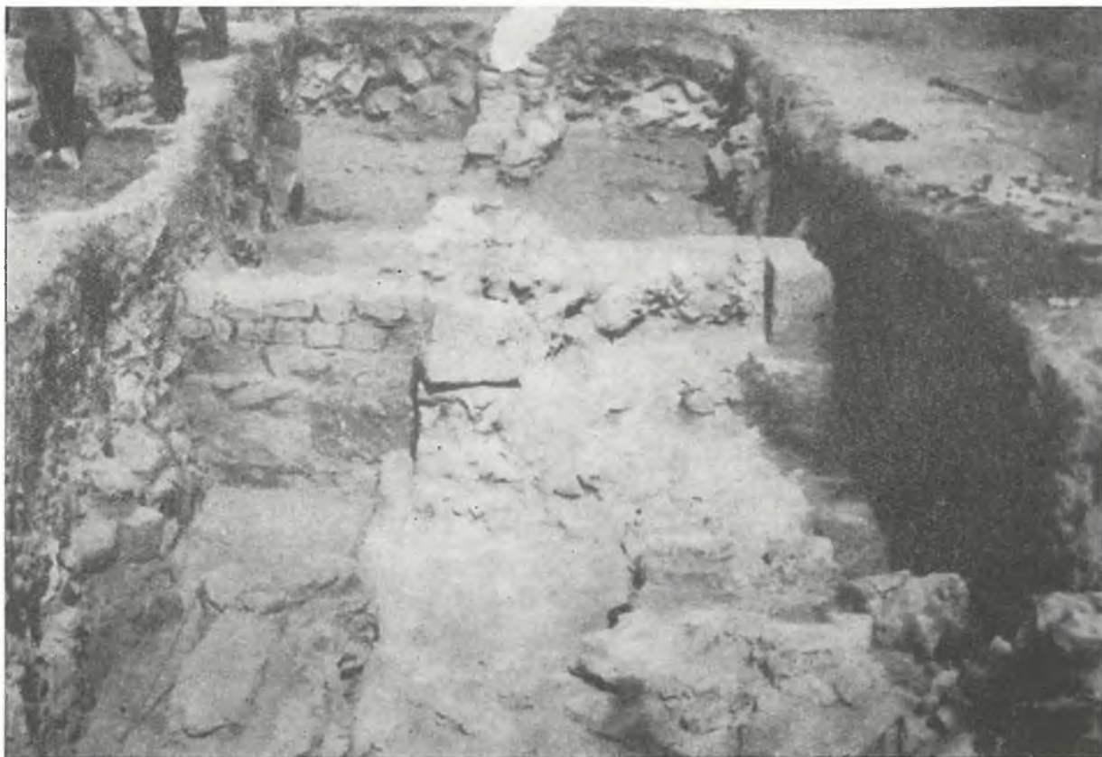
Рис. 13. Фрагмент южной стены западных ворот и ее фундамента и остатки оборонительной стены (правой стороны). Участок V
