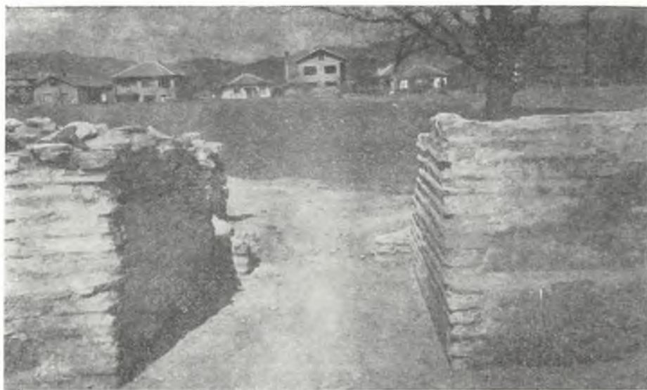
Обр. 23. Потерна VIII на външната северна крепостна стена Fig. 23. Poterne VIII du mur d'enceinte extérieur nord
