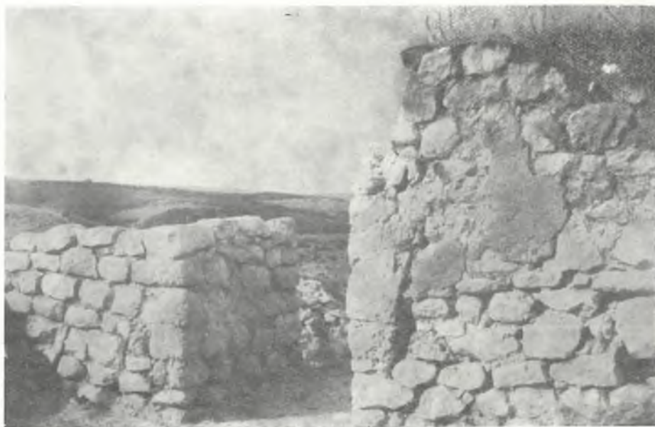
Обр. 11. Част от помещение 6 с водонепропускливата мазилка Fig. 11. Une partie du local 6 avec le crépi imperméable
