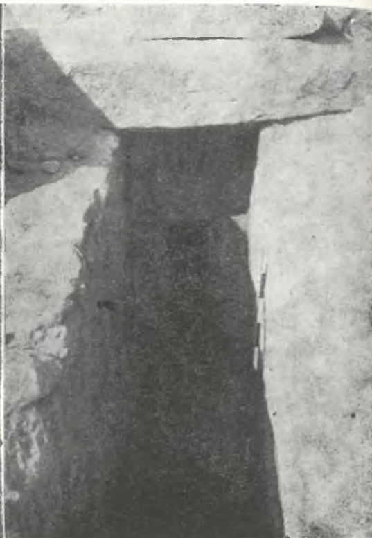
Обр. 15. Отточен канал под източната порта (гледан отвън) Fig. 15. Canal d'écoulement des eaux sous la porte est (vu de l'extérieur)
