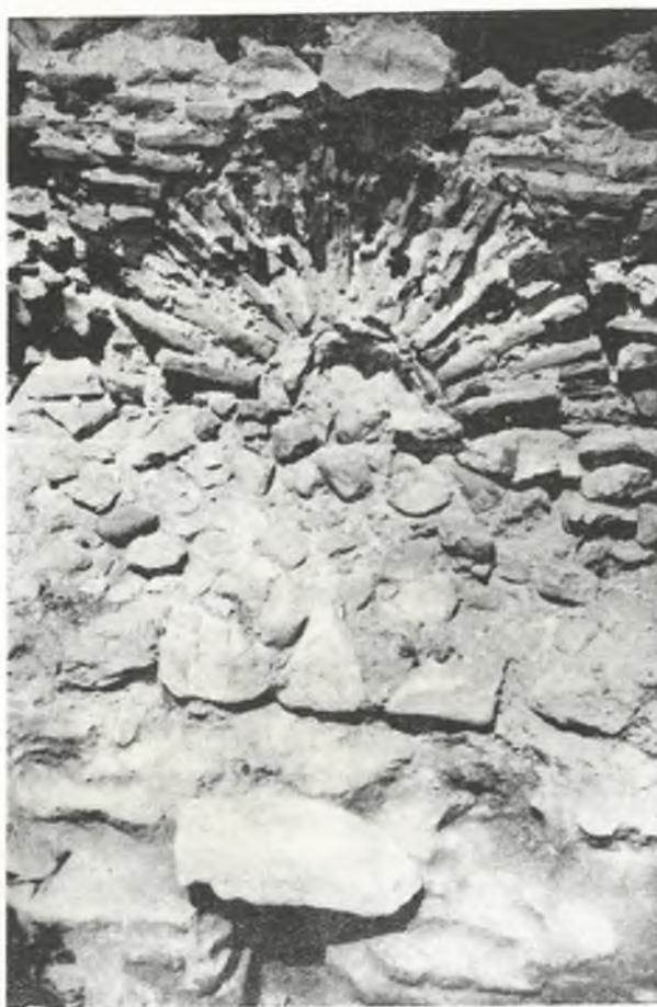
Обр. 10. Отточен канал на западната крепостна стена Fig. 10. Canal d'écoulement des eaux du mur d'enceinte ouest
