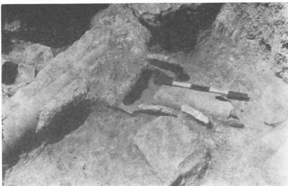
Обр. 11. Водопровод 1 и 2 Fig. 11. Conduites d'eau 1 et 2
