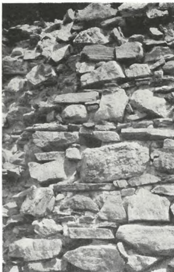
Обр. 1. Градеж на крепостния зид Fig. 1. Construction du mur d'enceinte
