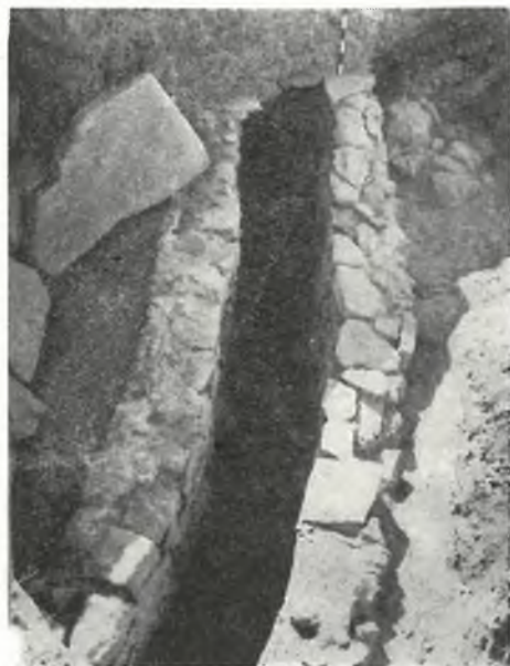
Рис. 7. Канал в районе северо-западного угла городской стены. III участок
