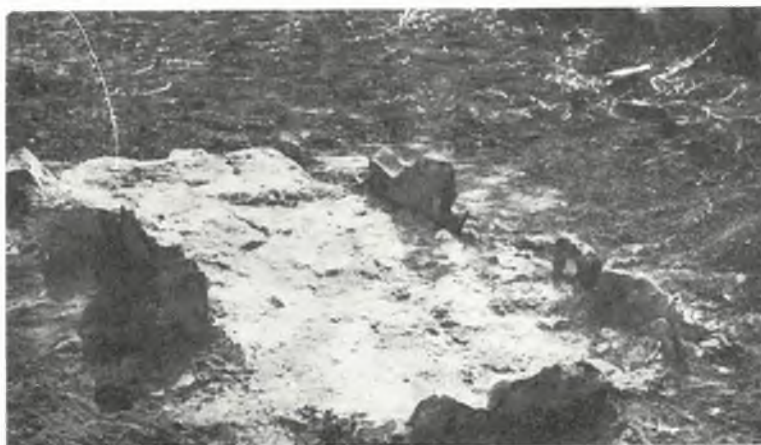
Обр. 14. Корито за приготвяне на хоросан Fig. 14. Baquet servant à la préparation du mortier
