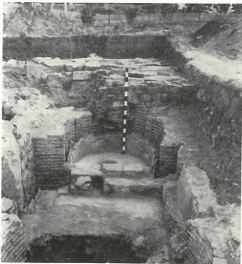
Рис. 19. Бассейн с кирпичной обмуровкой. Участок IV
