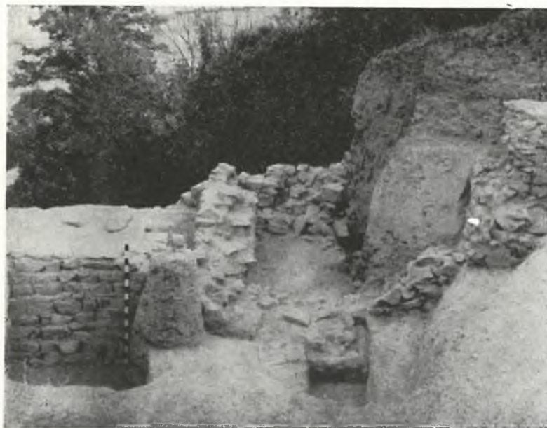
Рис. 12. Северо-западный угольник городской стены. Участок III
