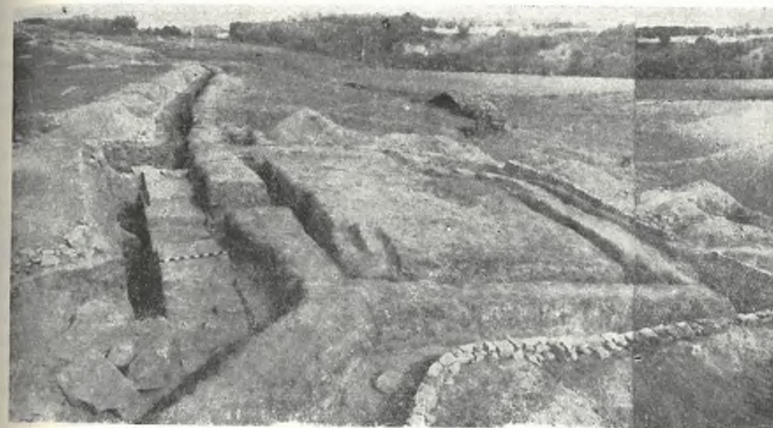
Рис. 9. Башня № 4 — вид с юго-запада
