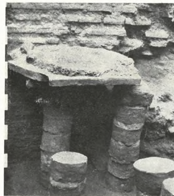
Рис. 22. Западная часть гипocaustума с сохранившимися обломками суспензуры и колонками суспензуры
