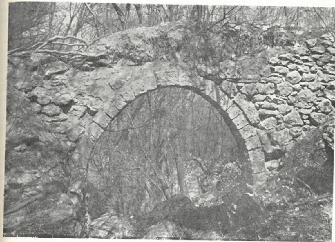
Обр. 9. Каменният акведук върху Хамамдере в съседство с Бакурияновия замък Fig. 9. Aqueduc en pierre sur le ruisseau de Hamam-déré aux environs du château de Bacuriani
