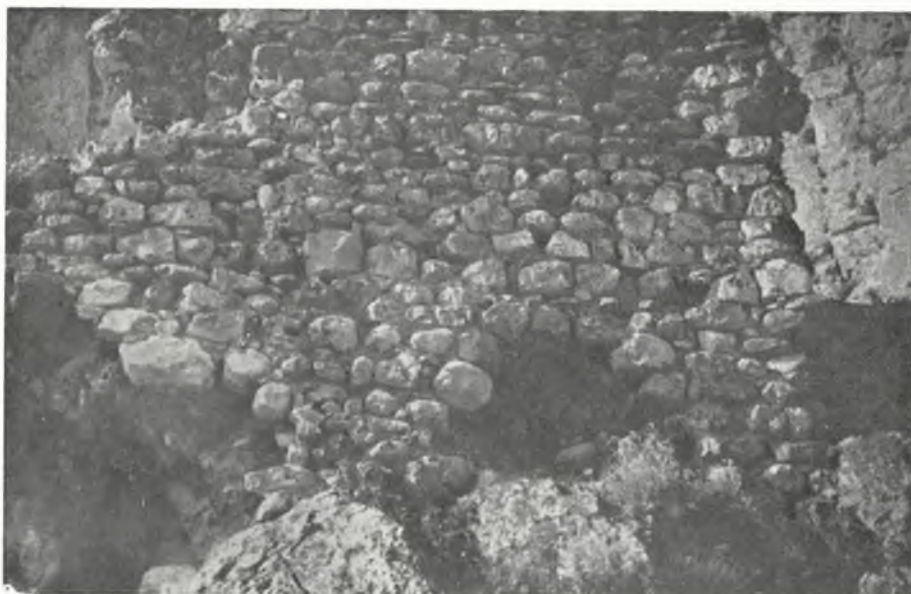
Обр. 4. Част от крепостната стена в местността „Градището“ Fig. 4. Partie du mur d'enceinte au lieu dit „Gradištë“
