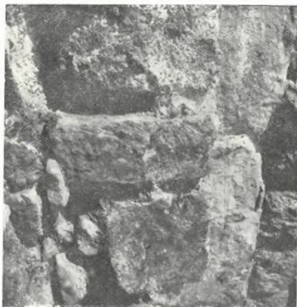
Обр. 6. Субструкции и цокъл на северната стена западно от северната порта
