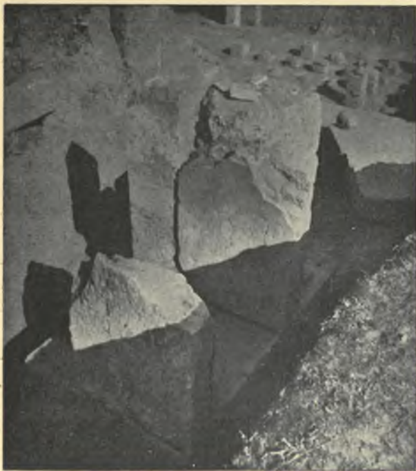
Обр. 214. Първият южен вход на помещение В. Fig. 214. Première entrée méridionale de la pièce B.
