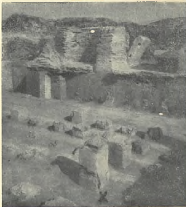
Обр. 207. Тухлени колонки от хипокауста в помещение А. Fig. 207. Piliers de briques de l'hypocauste de la pièce A.
