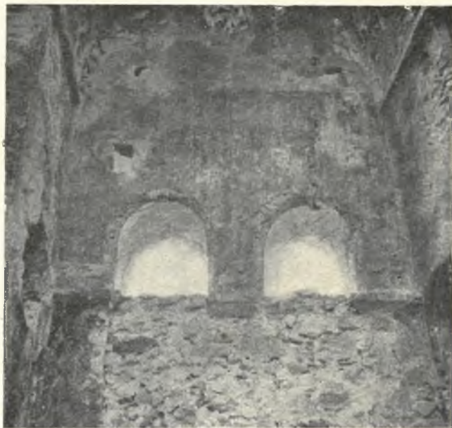
Обр. 8. Двоен прозорец на северната стена в църквата Св. Георги в Козяк, гледан отвътре Fig. 8. La fenêtre jumelée du mur nord vue de l'intérieur
