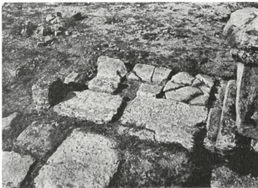
Abb. 198. Gebäude A. Nördliche Öffnung des Portikus. Blick von Osten
