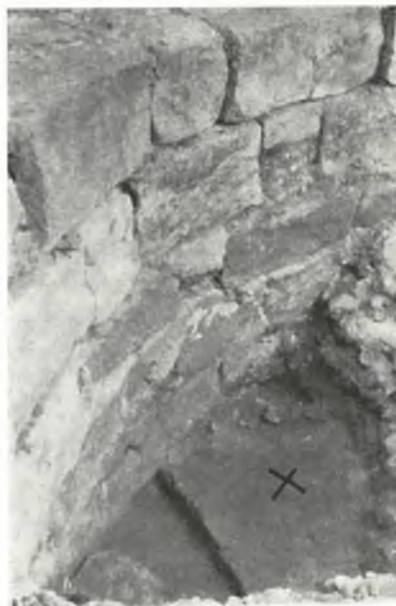
Обр. 180. Хоросанена подложка (X) подъ апсидата на Голѣмия дворецъ Abb. 180. Mörtelunterlage unter der Apsis des Grossen Palastes
