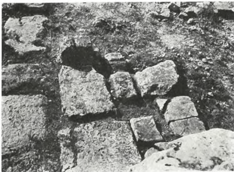
Abb. 197. Gebäude A. Nördliche Öffnung des Portikus. Blick von Norden
