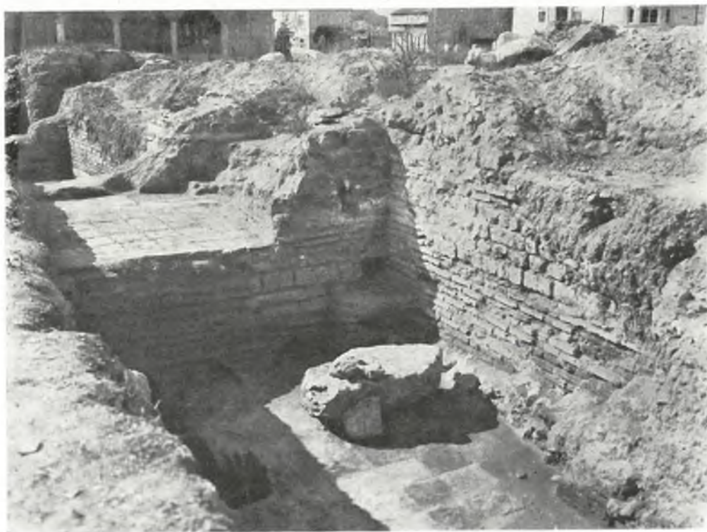
Обр. 319. Часть отъ римската постройка при Римската кула въ Варна Abb. 319. Ein Teil von dem römischen Bau bei dem Römischen Turm in Varna
