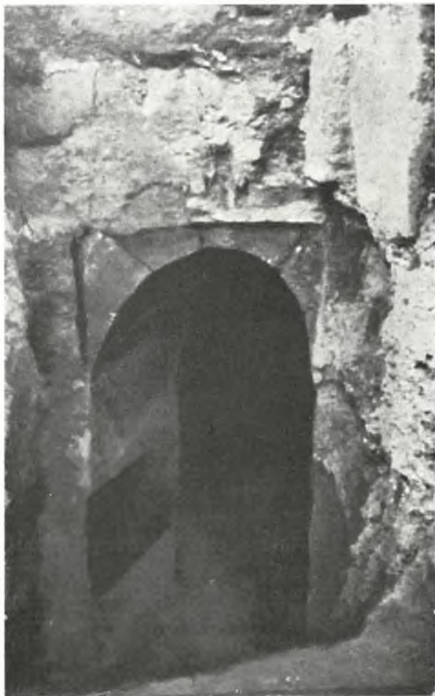
Abb. 207. Unterirdischer Gang durch die Grenzmauer
