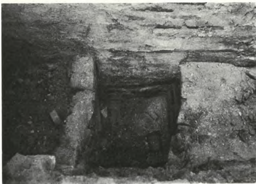
Abb. 228. Gebäude H. Drainageleitung. Abfluss-Stelle aus dem Kanal in der südlichen Mauer von Raum 1. Blick von Süden
