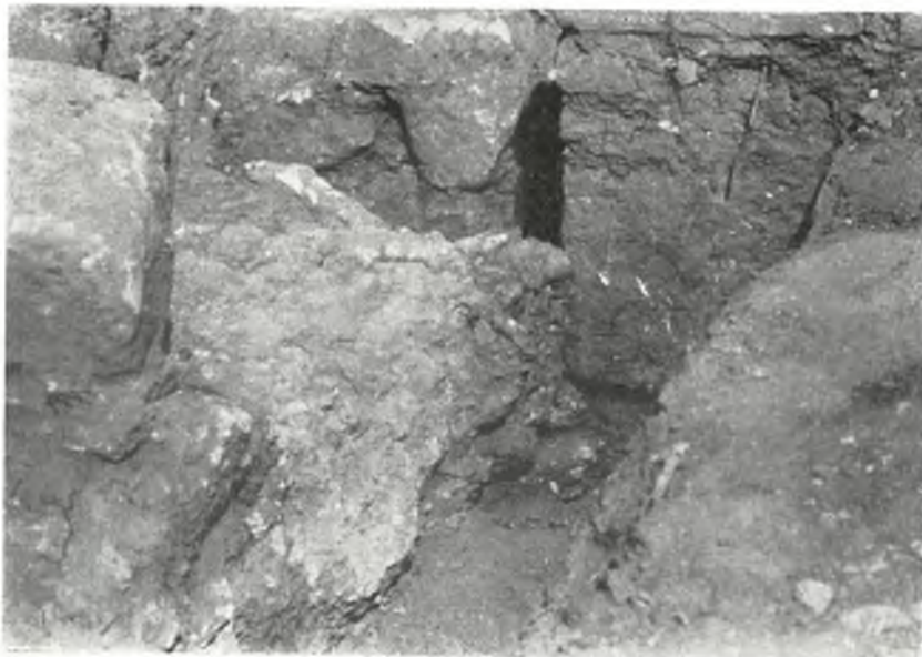
Abb. 221. Anschluss-Stelle zwischen den Gebäuden C (rechts) und F (links)
