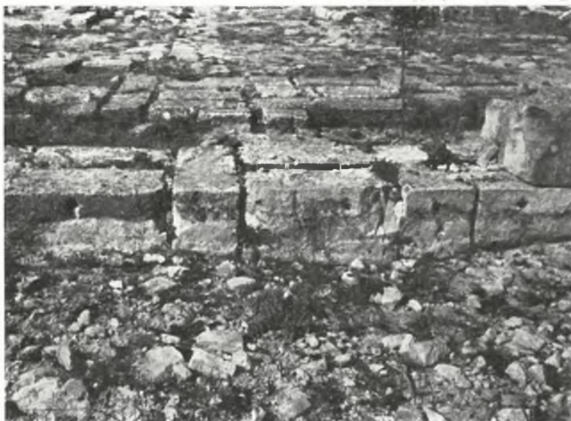
Abb. 209. Gebäude B. Blick nach Westen. Im Vordergrund: Raum 1. Zustand vor der Ausgrabung der Hypokaustanlage
