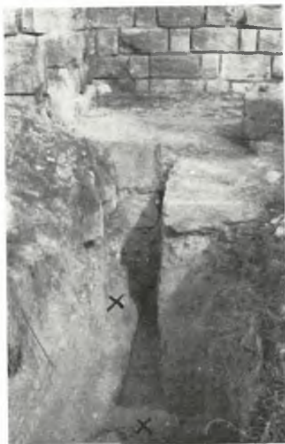
Обр. 177. Хоросанена подложка (X) подъ южната стена на Голѣмия дворецъ Abb. 177. Mörtelunterlage (X) un- ter der Südmauer des Grossen Palastes
