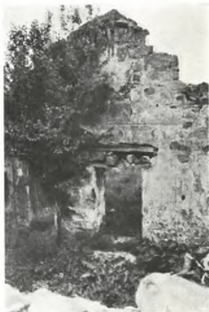
Обр. 279. — Западната стена на църквата въ Балша отвътре.
